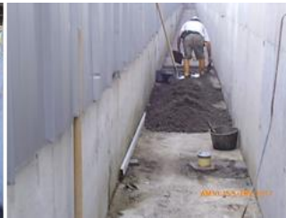
Proceso del vaciado de mortero de nivelación piso 2 , viga canal el costado noroccidental.
