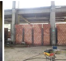
Encofrado y Fundida de viguetas, y vigas dintel confinamiento muro h15 piso 1 Ejes SA1-2, SAB1-2, SB1-2, SC1-2, SD1-2, SGH1-4, Mampostería h15 en Piso 2 Costado Noroccidental, Piso 1 costado Norte, oriental y sur, Sótano 1 área cuarto de seguridad & control; columnetas de confinamiento piso 1 gran salón costado norte, oriental y sur .
