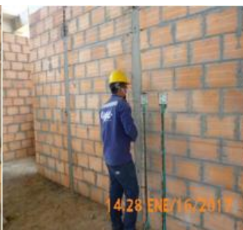
Instalación de ductos plásticos para salida de tomacorrientes e interruptores . Instalación de ductos EMT para red de iluminación en Sótano 2.
