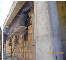
Encofrado y Fundida de viguetas, y vigas dintel confinamiento muro h15 piso 1 Ejes SA1-2, SAB1-2, SB1-2, SC1-2, SD1-2, SGH1-4, Mampostería h15 en Piso 2 Costado Noroccidental, Piso 1 costado Norte, oriental y sur, Sótano 1 área cuarto de seguridad & control; columnetas de confinamiento piso 1 gran salón costado norte, oriental y sur .
