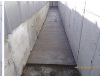
Proceso del vaciado de mortero de nivelación piso 2 , viga canal el costado noroccidental.
