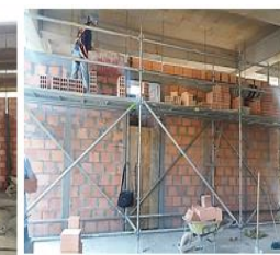
Encofrado y Fundida de viguetas, y vigas dintel confinamiento muro h15 piso 1 Ejes SA1-2, SAB1-2, SB1-2, SC1-2, SD1-2, SGH1-4, Mampostería h15 en Piso 2 Costado Noroccidental, Piso 1 costado Norte, oriental y sur, Sótano 1 área cuarto de seguridad & control; columnetas de confinamiento piso 1 gran salón costado norte, oriental y sur .
