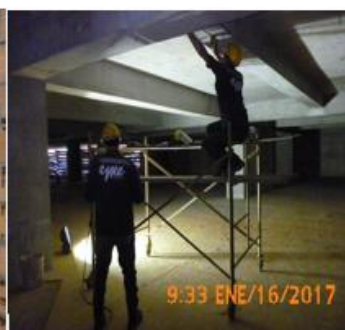
Instalación de ductos plásticos para salida de tomacorrientes e interruptores . Instalación de ductos EMT para red de iluminación en Sótano 2.
