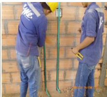
Instalación de ductos plásticos para salida de tomacorrientes e interruptores . Instalación de ductos EMT para red de iluminación en Sótano 2.
