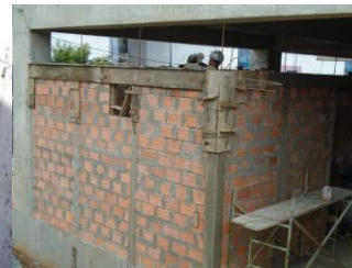
Vaciado de concreto para viga costado noroccidental enre (SA-SAB) (S1-S2)
