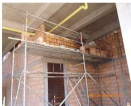
Construcción de mampostería H-15 (ampostería después de vigueta hasta la viga)
