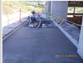
Proceso del vaciado de mortero de nivelación piso 2 , viga canal el costado noroccidental.
