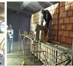
Encofrado y Fundida de viguetas, y vigas dintel confinamiento muro h15 piso 1 Ejes SA1-2, SAB1-2, SB1-2, SC1-2, SD1-2, SGH1-4, Mampostería h15 en Piso 2 Costado Noroccidental, Piso 1 costado Norte, oriental y sur, Sótano 1 área cuarto de seguridad & control; columnetas de confinamiento piso 1 gran salón costado norte, oriental y sur .
