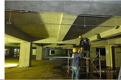
Instalación de ductos plásticos para salida de tomacorrientes e interruptores costado norte gran salón. Instalación de ductos EMT para red de iluminación en Sótano 2.
