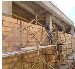
Encofrado y Fundida de viguetas, y vigas dintel confinamiento muro h15 piso 1 Ejes SA1-2, SAB1-2, SB1-2, SC1-2, SD1-2, SGH1-4, Mampostería h15 en Piso 2 Costado Noroccidental, Piso 1 costado Norte, oriental y sur, Sótano 1 área cuarto de seguridad & control; columnetas de confinamiento piso 1 gran salón costado norte, oriental y sur .
